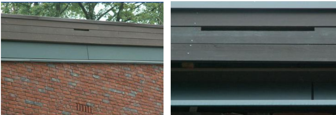
Figuur 4: Daklijsten met toegang tot vleermuisverblijf.
