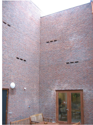
Figuur 2: Voorbeelden van inbouwkasten. Links= inbouwkaste en rechts= inbouwkast ingemetseld in gevel (VZZ).
