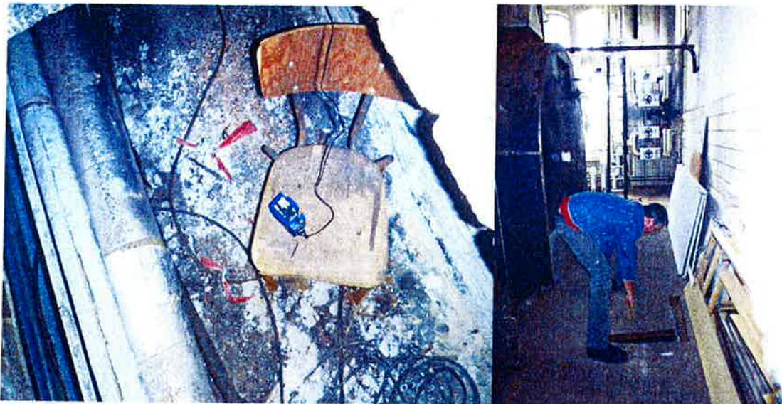
Foto 3 en 4: Meetsituatie kruipruimte ketelhuis/wasserij (2A)
