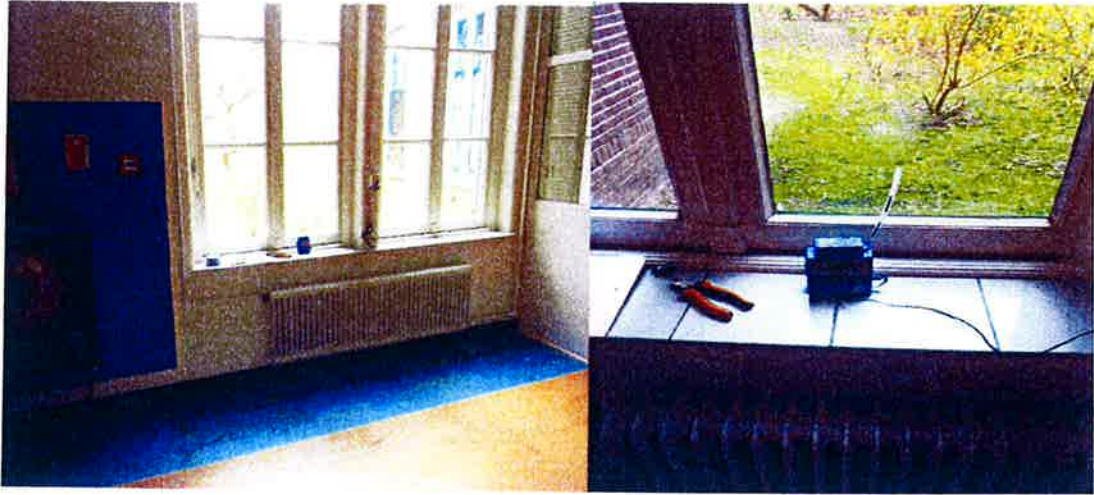
Foto 17 en 18: Meetsituatie Binnenluchtmetingen Gebouw De Loet (9A)
