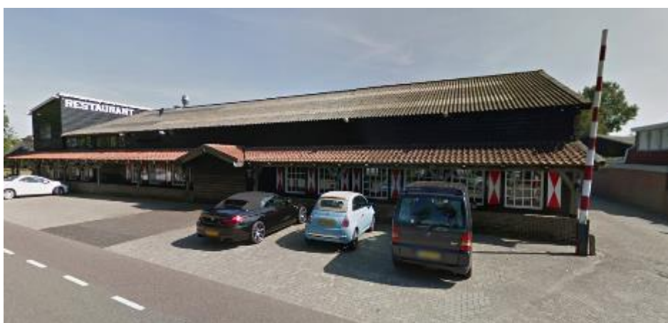
Figuur 2.1: Hoofdgebouw Jachthaven Laamens aan de Geesterweg
