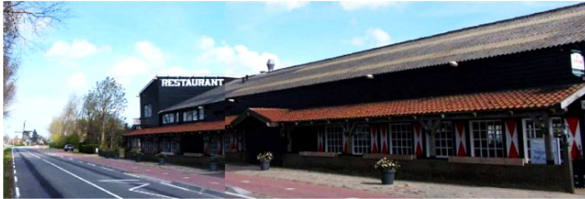
Bestaande hoofdgebouw jachthaven aan de Geesterweg
