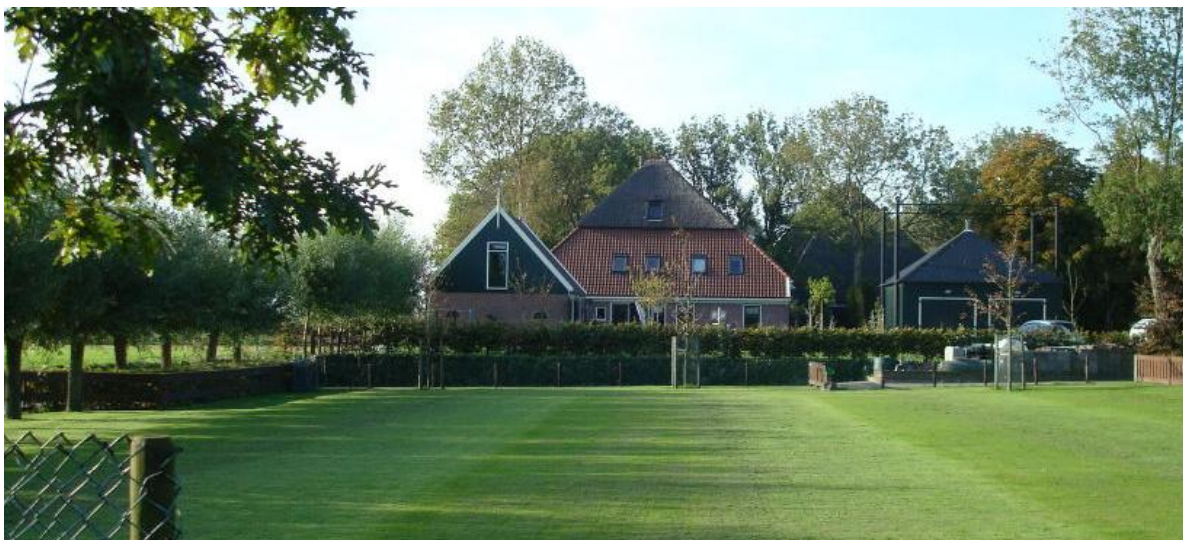
Afbeelding 17. aangrenzende streekeigen boerderij Sluisweg 9
