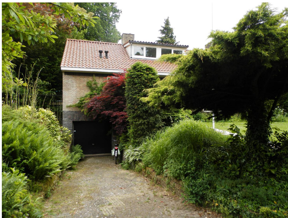
Afbeelding 1. De woning die wordt gesloopt.
