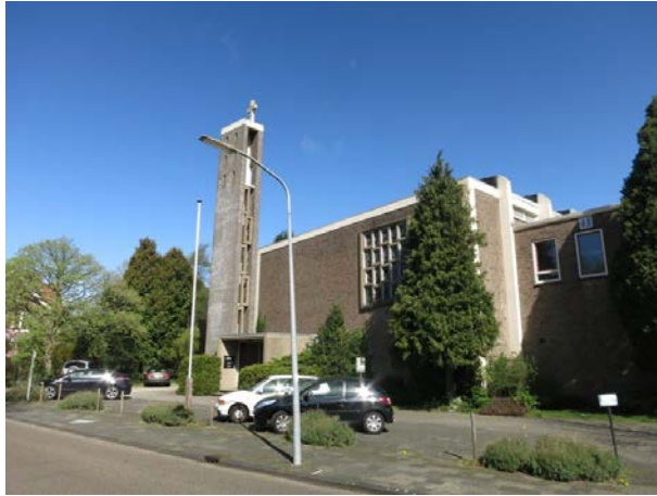
16. Overzicht van het rechterdeel van de zuidgevel van Vijverwegkerk vanuit het zuidoosten.
