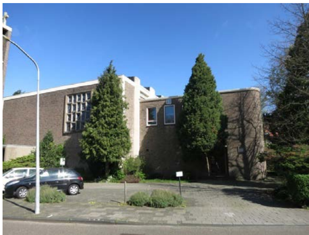
17. Overzicht van de zuidgevel met de teruggelegen en lagere zijvleugel met afgeronde hoek.
