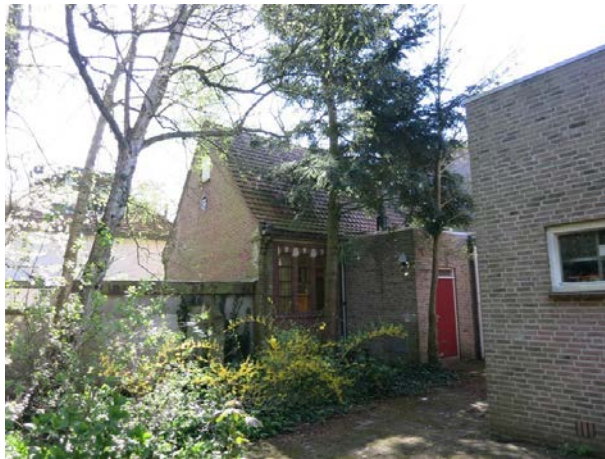
20. Gezicht op de noord- en westgevel van de consistorie-hobbyruimte (links). Opvallend zijn de rijk versierde geblokte bovendorpels van de gekoppelde Tudorvensters. Tegen de westgevel staat een aanbouw uit de jaren 70 van de 20e eeuw. Geheel rechts de nieuwbouw van de kerk uit de jaren 70 van de 20e eeuw.
