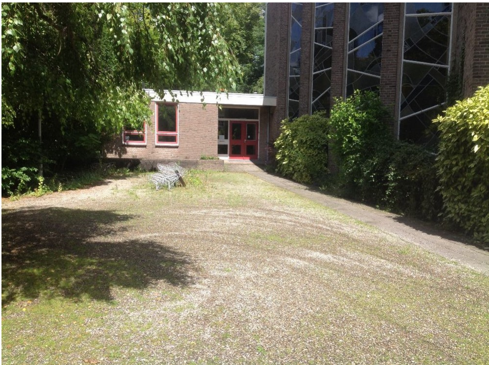
Foto 4: Zijkant van het kerkgebouw gezien in noordoostelijke richting.
