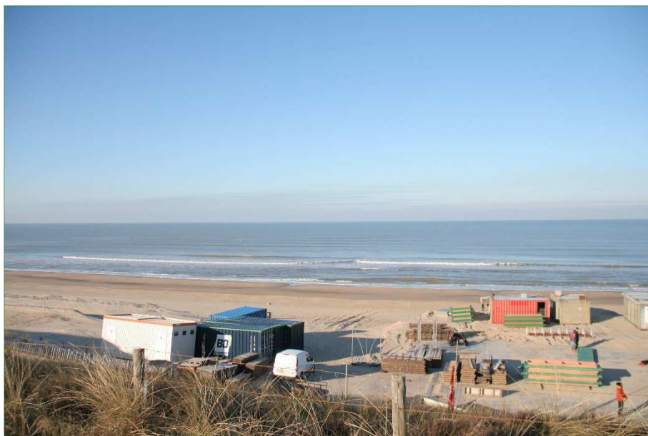
Opbouwwerkzaamheden van het tijdelijke paviljoen.
