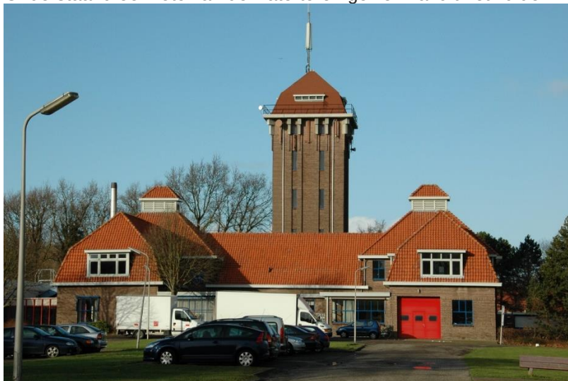
Figuur: watertoren gezien vanuit het zuiden
