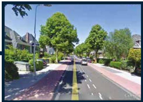
JULIANALAAN: VRIJLIGGEND FIETSPAD
