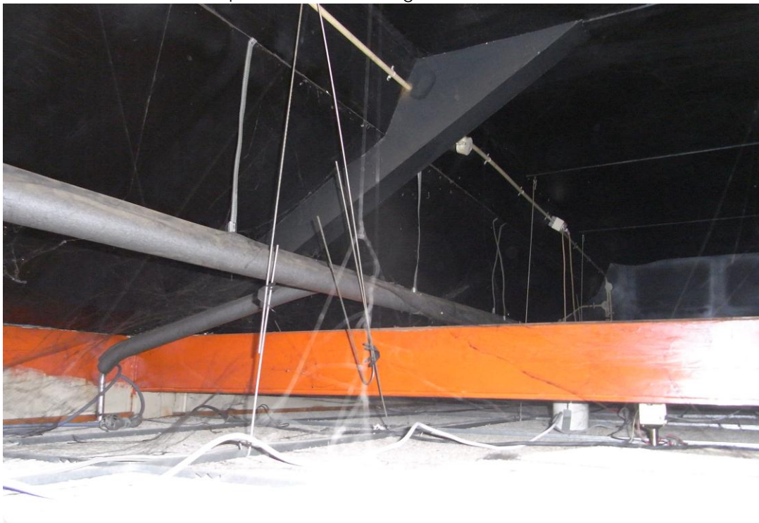
Foto 10 Ruimte boven het plafond van het clubgebouw
