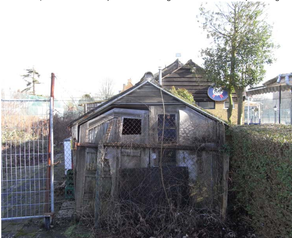
Foto 6 Opstal aan de westzijde van het clubgebouw vanuit westelijk richting.
