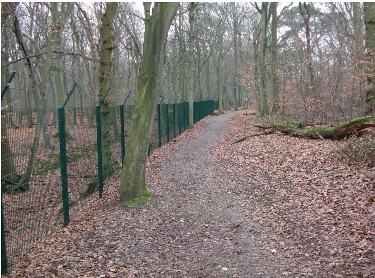
Figuur 8 Voorbeeld van een reeds geplaatst raster
