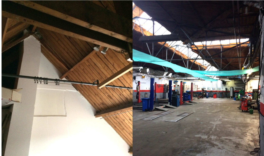
Afbeelding 7 en 8. De binnenzijde van de zolder van het woonhuis en de garage
