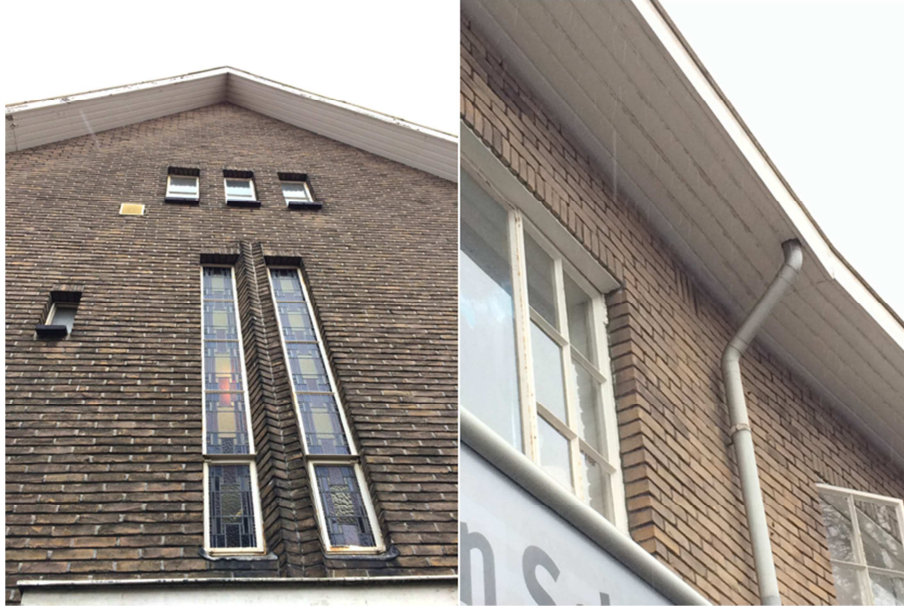
Afbeelding 5 en 6. De zijgevel en voorgevel met open stootvoegen
