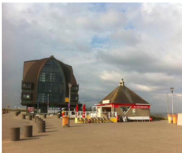
aanzicht bestaande situatie
