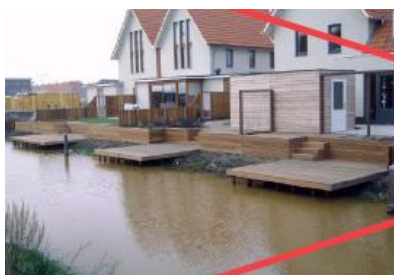
Niet: bouwkundige uitstraling van de oever
