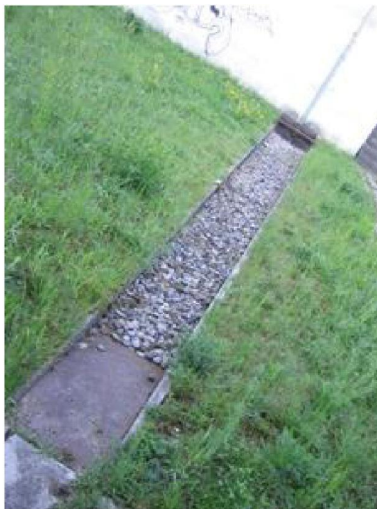
Figuur 1: Principe afvoeren hemelwater Figuur 2: Principe afvoer particulier terrein via zichtbare goot
