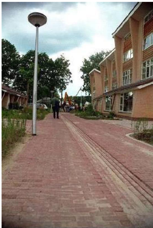
Figuur 1: Principe afvoeren hemelwater Figuur 2: Principe afvoer particulier terrein via zichtbare goot
