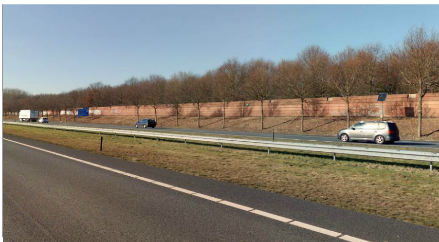
Figuur 3.2: Impressie van de huidige geluidsafscherming langs de Rijksweg A27 ter hoogte van de woonwijk Bijvanck
