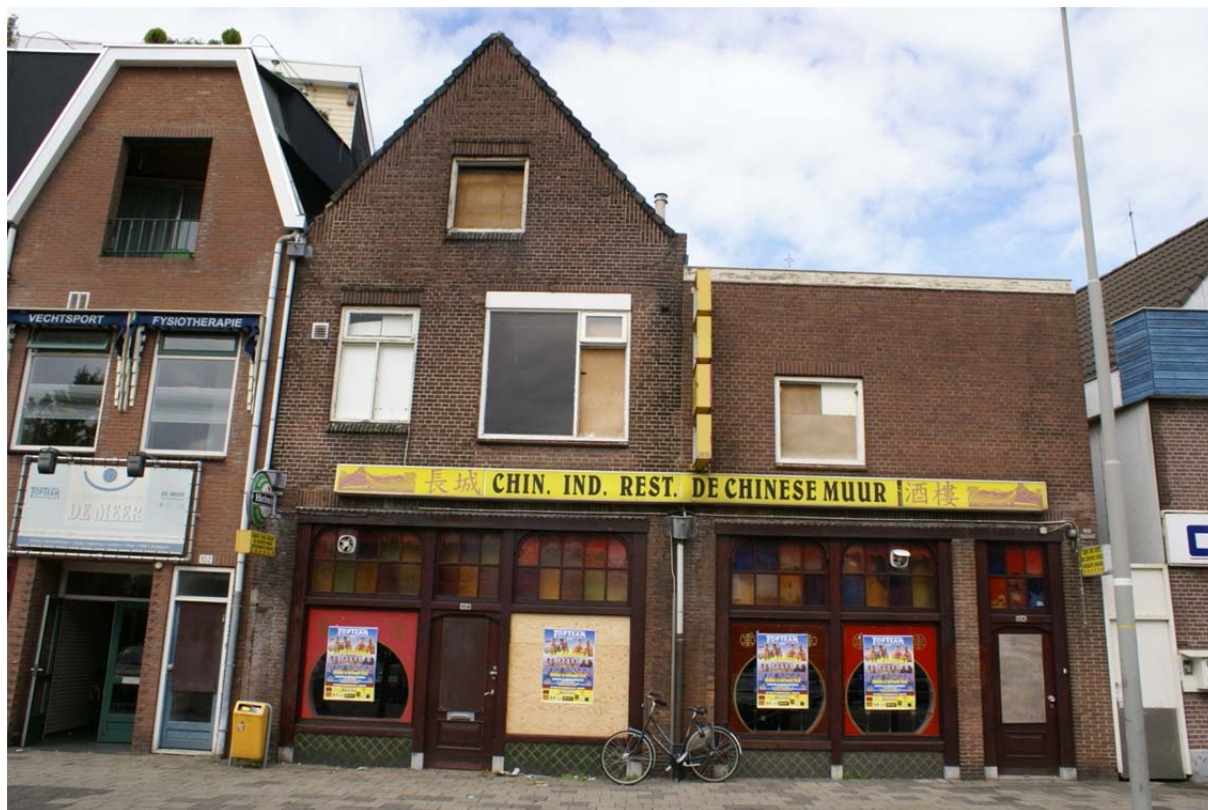
Te slopen bebouwing - voormalig Chinees restaurant met bovenwoning
