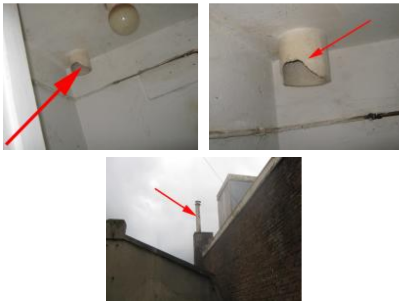
foto: 2, buis (cement)
