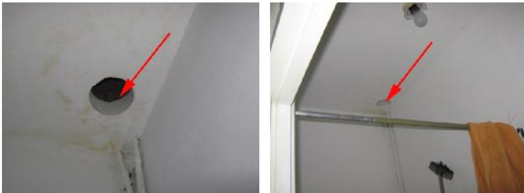
foto: 1, buis (cement)
