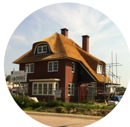
woningen in aanbouw langs de Bankenlaan
