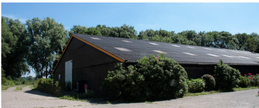
Foto 6: achterzijde van de ligboxenstal op het achtererf (gebouw wordt gesloopt)
