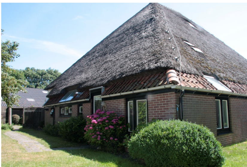
Foto 3: achterzijde waar zich de tweede woning bevindt
