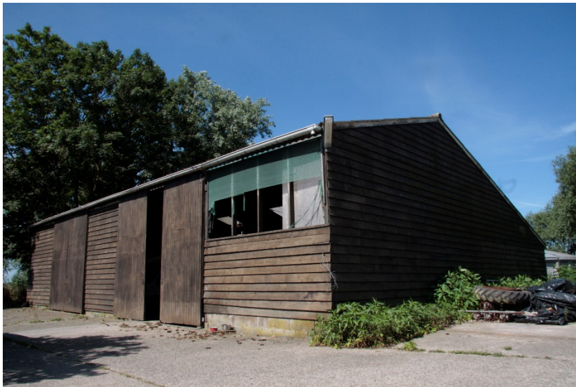
Foto 7: huidige machineloods op het achtererf die wordt gesloopt
