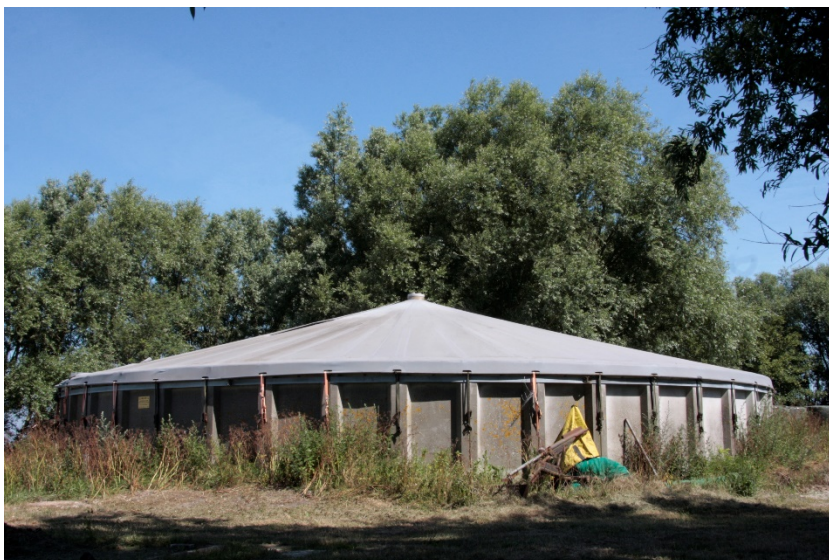
Foto 8: huidige mestsilo op het achtererf die wordt gesloopt
