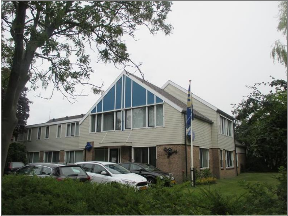
Figuur 2.2 Foto te wijzigen pand in bestaande situatie (bron: Google Earth)
