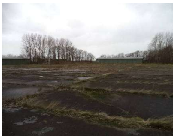
Foto 6: overzichtsfoto aanwezige verhardingen
