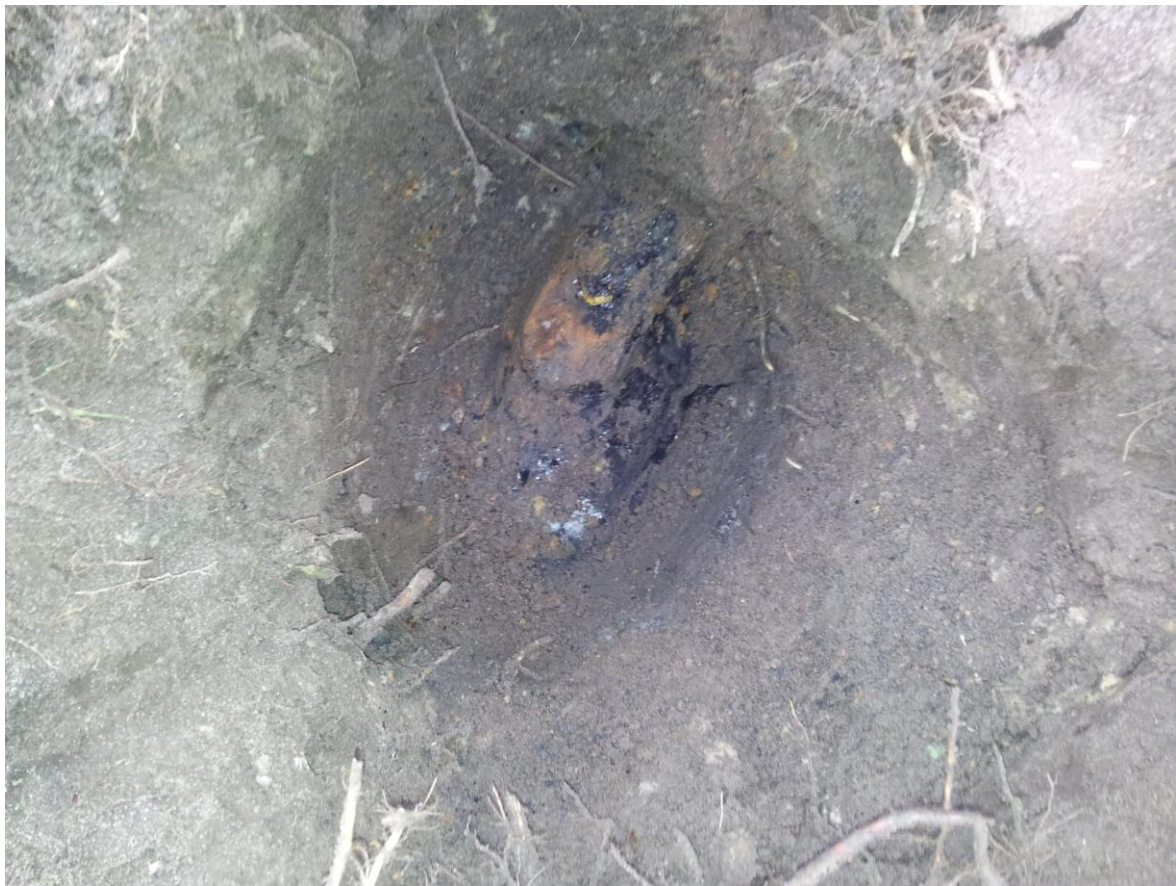
Mof kabel in proefvak 15
