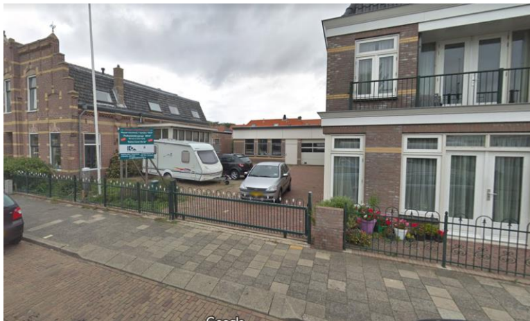
Figuur 4: Aangezicht bouwperceel vanaf de Voorstraat
