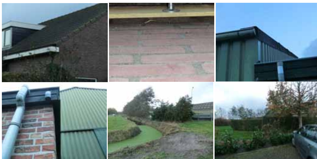
Figuur 3.4b Potentieel verblijfplaats vleermuizen en foerageergebied
