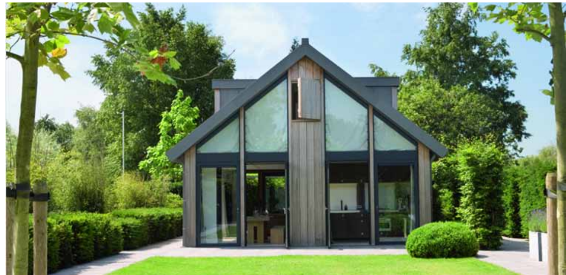
Eenvoudige hoofdvorm welke refereert naar schuurvorm, met eigentijdse uitstraling door gevelindeling, ingetogen kleur en materiaalgebruik
