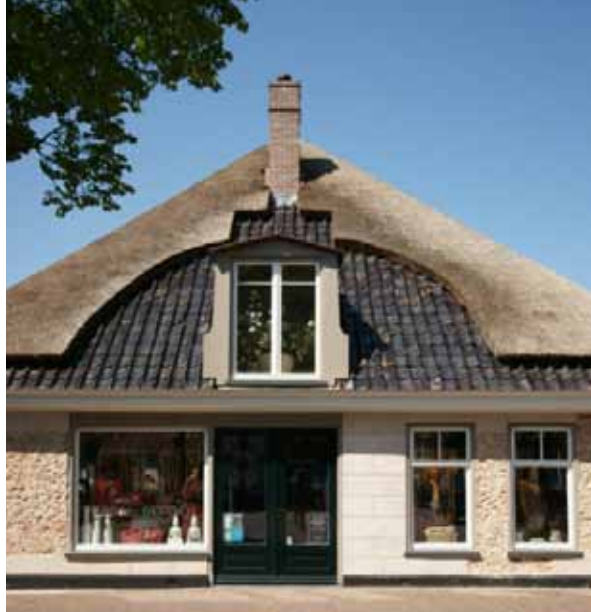
Stolpboerderij, piramidedak, dak van riet en pannen
