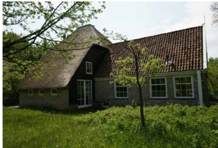
Materiaalgebruik riet, pannen, rode baksteen, zwarte houten gevel en witte kozijnen, aandacht voor verhoudingen
