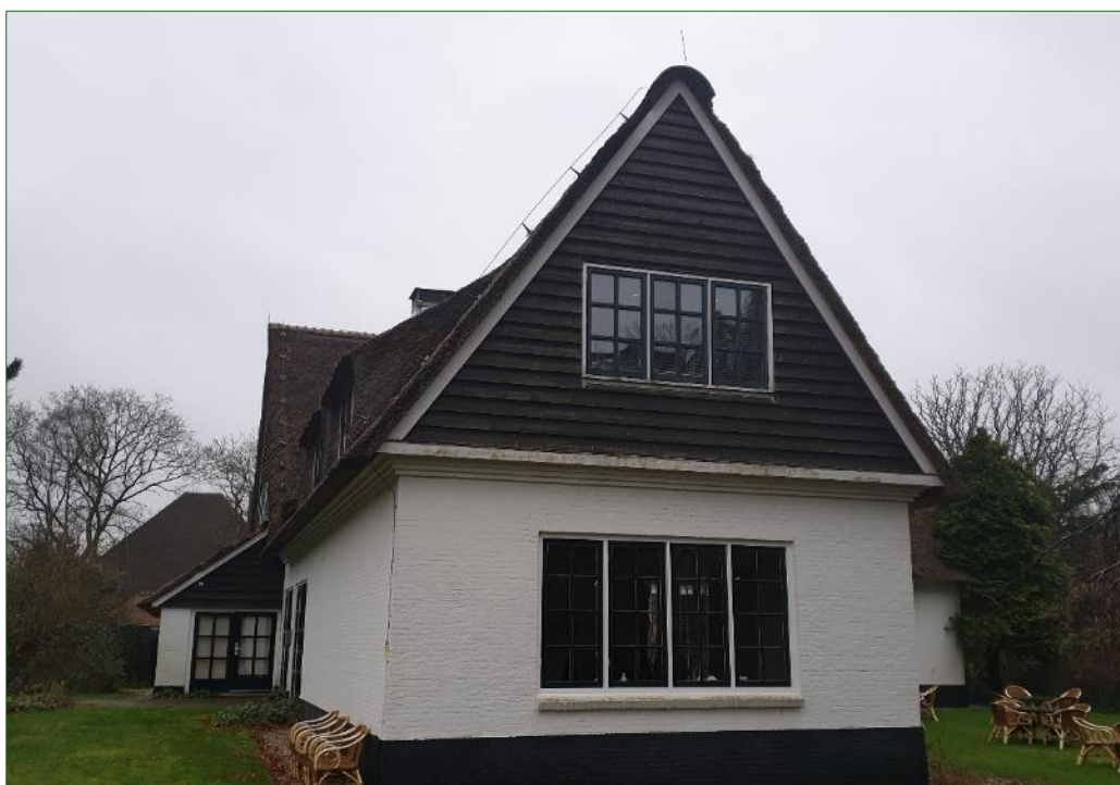
Het te slopen gedeelte van de huidige woning in het plangebied.
