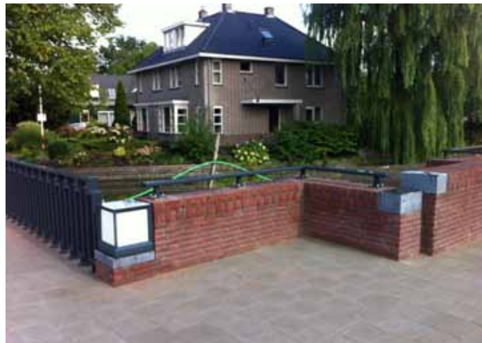
volledig gemetselde brug aan de Purmerenderweg
