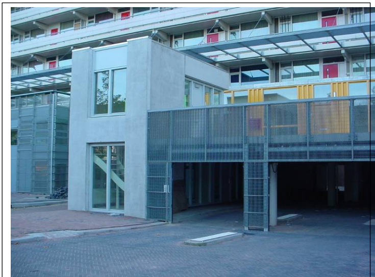
Afbeelding: ingang parkeergarage Kruitberg
