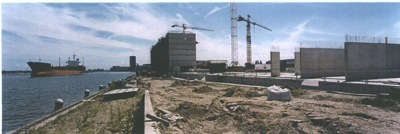
voorjaar 1996: woningen in aanbouw
