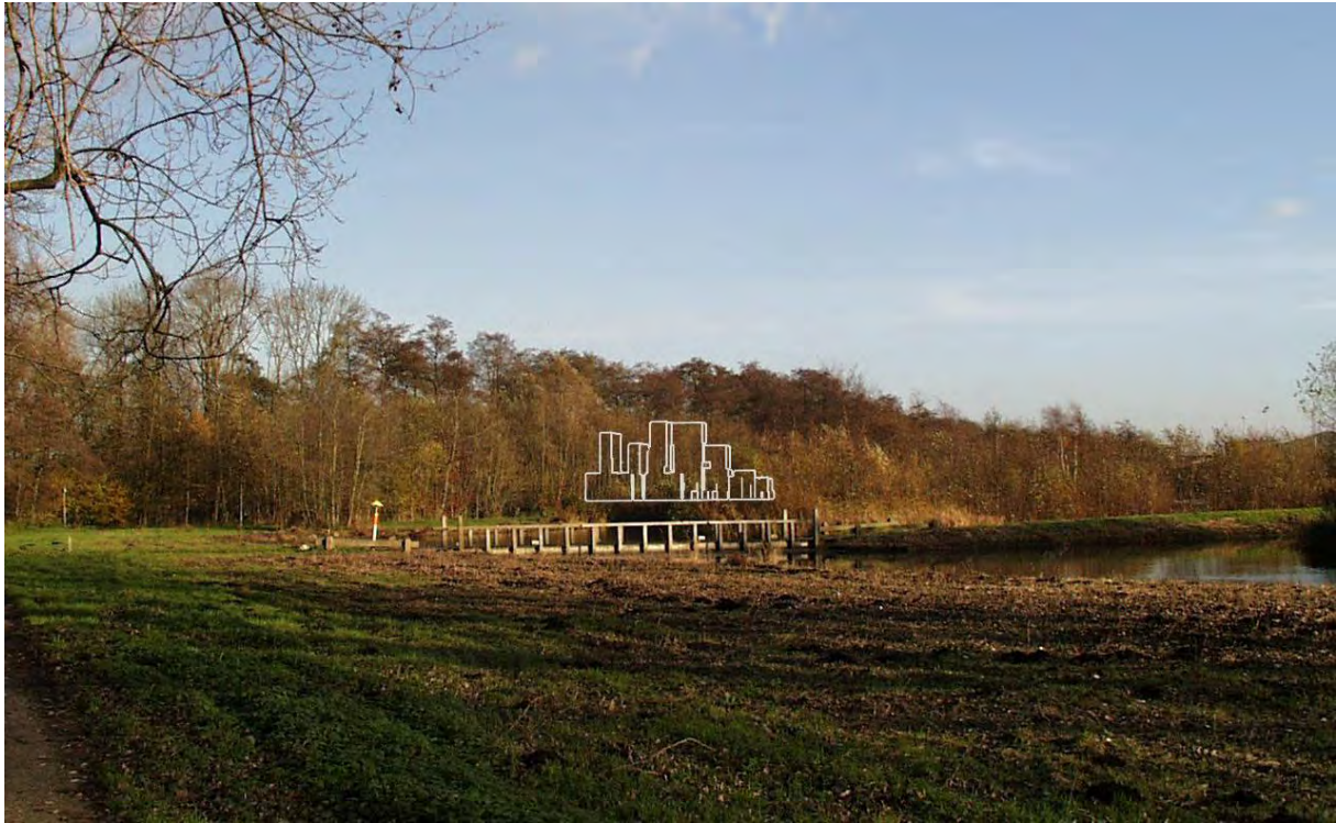
Afb. 5.8. Vanuit meerdere plaatsen in het Amsterdamse Bos zijn foto's genomen waarin de nieuwbouw van Gershwin is geprojecteerd, een van deze foto's is hierboven opgenomen. Vanuit het Amsterdamse Bos is Gershwin niet of nauwelijks te zien.
