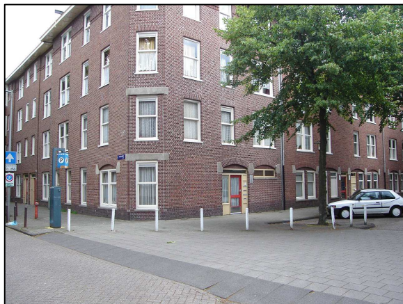
Afbeelding: te slopen bebouwing langs de Laing's Nekstraat
