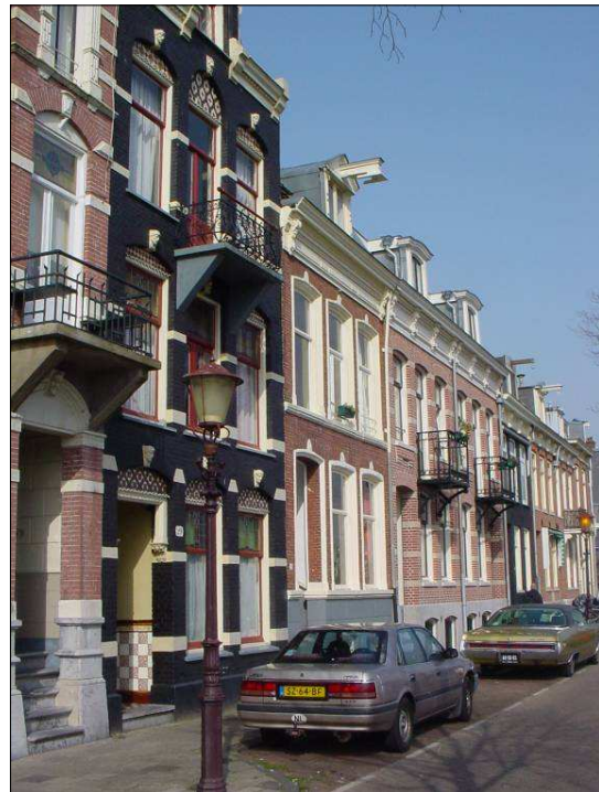
Afbeelding: laagbouw aan de Transvaalkade
