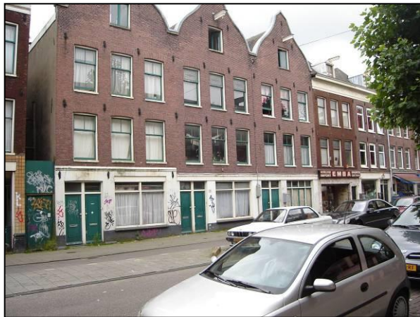
Afbeelding: enkele bestaande panden in project 0.21
