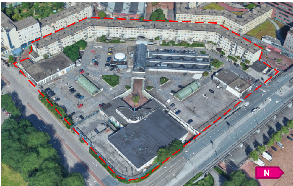
Figuur 1 Overzicht huidige Cluster 7 Amsterdamse Poort, gezien vanuit het oosten (Bron: Google Maps)
