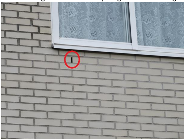
Fig. 11: Eén van de vele open stootvoegen in de flat.
