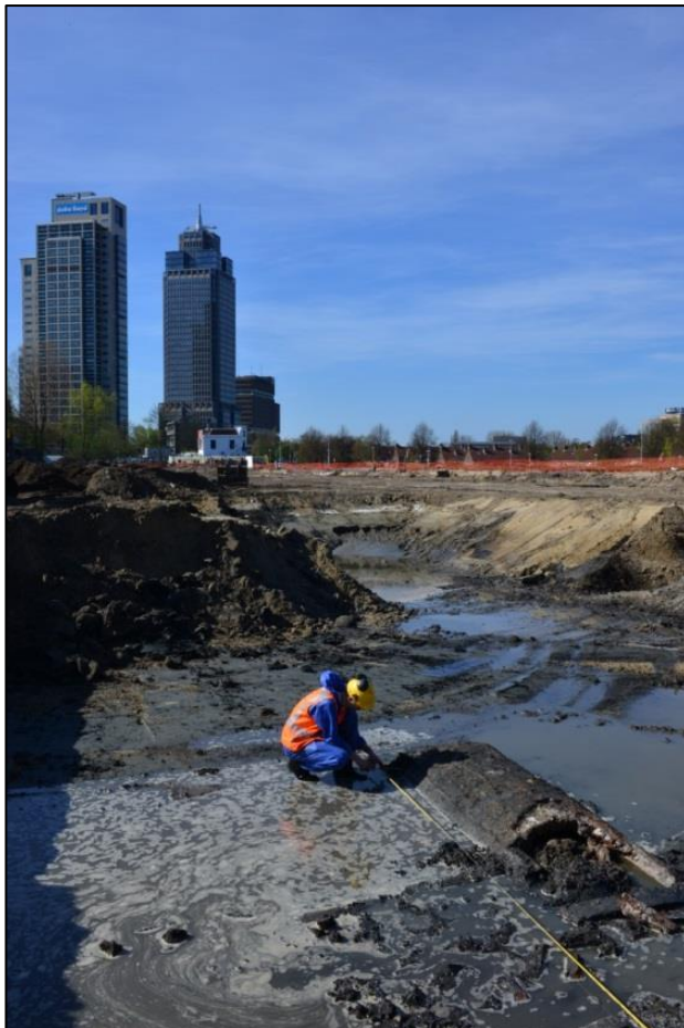
10 De waterkelder op het voormalig landgoed van de buitenplaats Waslust.
