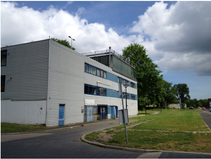
twee van de drie te slopen parkeergarages
