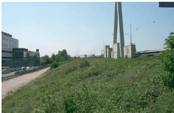
De A10 oost wordt verbreed door het talud gedeeltelijk te vervangen door rechte wanden.
