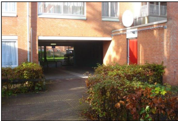
Afbeelding: een onderdoorgang in Holendrecht Noord
