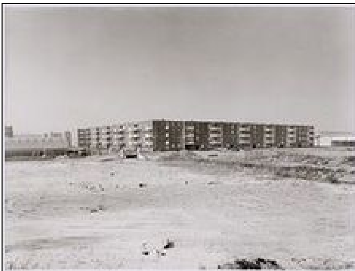
7 De wijk Gein II in aanleg (foto SAA).
