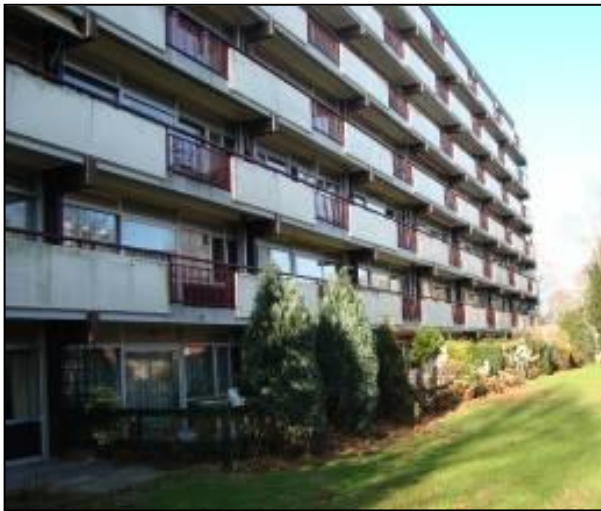
Afbeelding: De meeste seniorenwoningen op de begane grond ter plaatse van Garstkamp beschikken over een tuin. Deze tuinen grenzen aan het openbare groen dat het hele complex nagenoeg omsluit.
