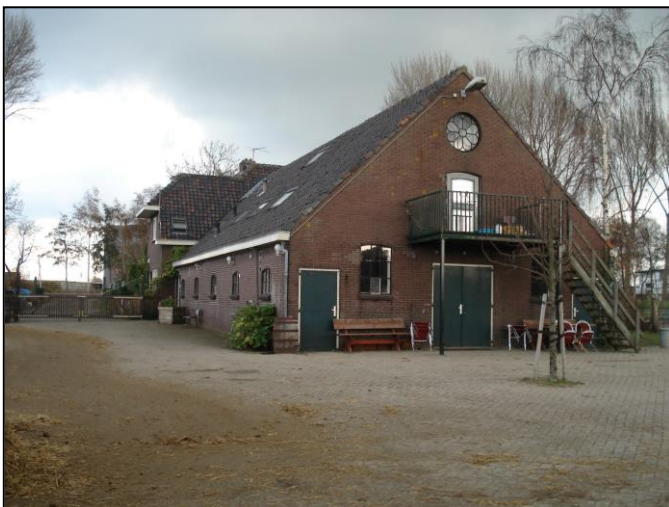
Afbeelding: De boerderij gezien vanaf de achterzijde. De achterzijde van het bouwwerk wordt gebruikt voor manege gerelateerde voorzieningen.
