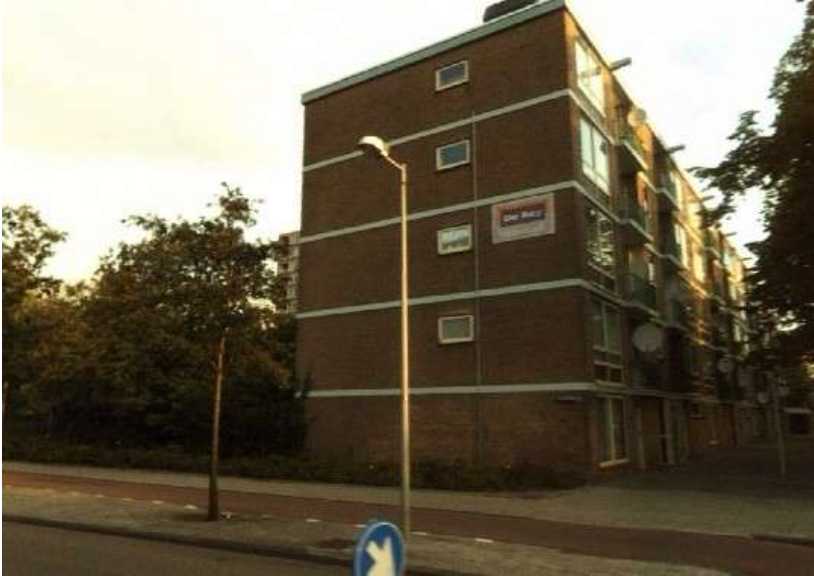
Flatgebouw langs de Vlaardingenlaan, mogelijke verblijfplaats van vlemmuizen op de kopse kant
