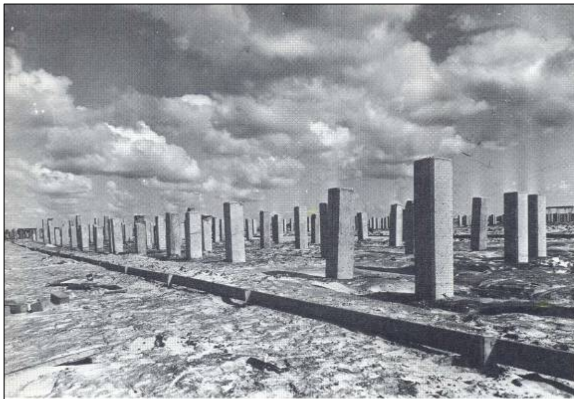
Afbeelding: Voorgeheide palen voor Geuzenveld (1953)
