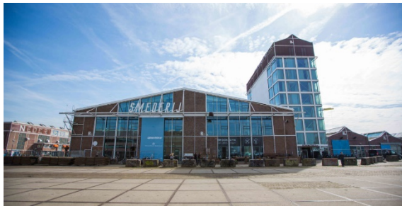
In de metalen dakrand van de Smederij aan de Noordwestzijde broeden 8 paren.
