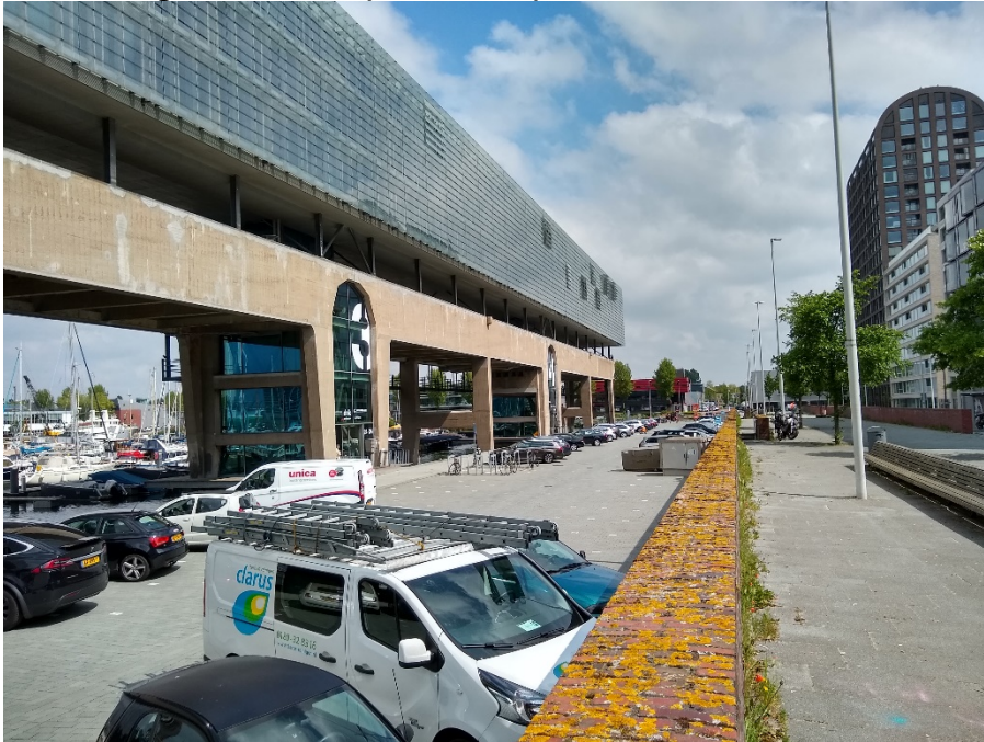
Foto richting het noorden op het Kraanspoor (West)
