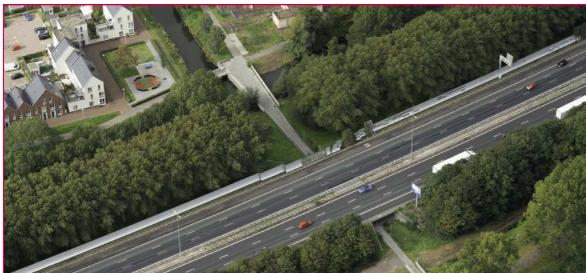
Figuur 3.1: Impressie van het bestaande geluidsscherm aan de westzijde van de Rijksweg A10 ter hoogte van het plangebied
