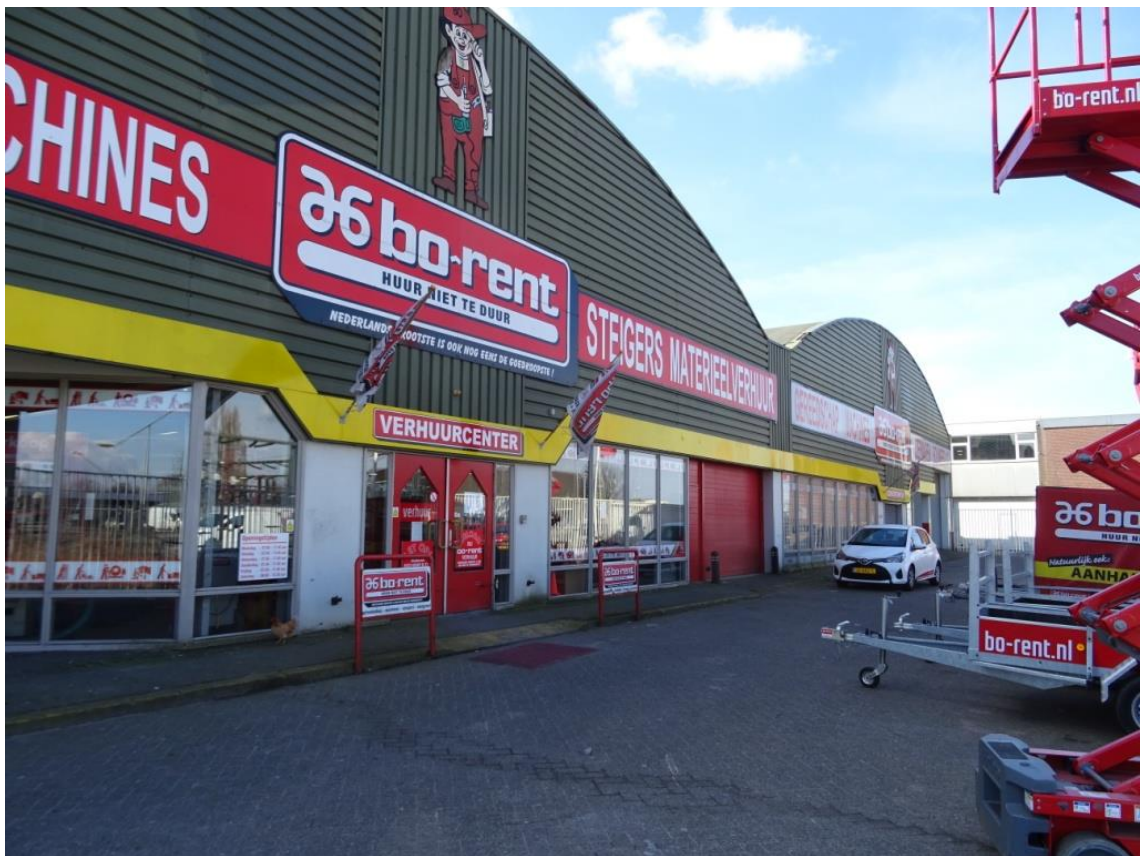
Loodsen met verhard voorplein
