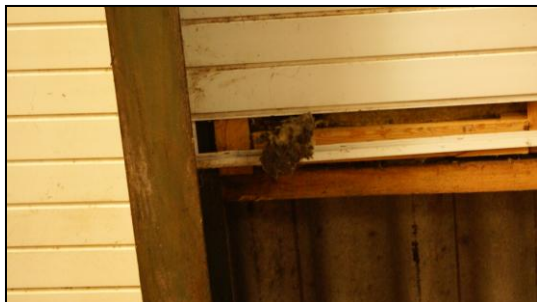
Afbeelding 4: Beplating met spleten
