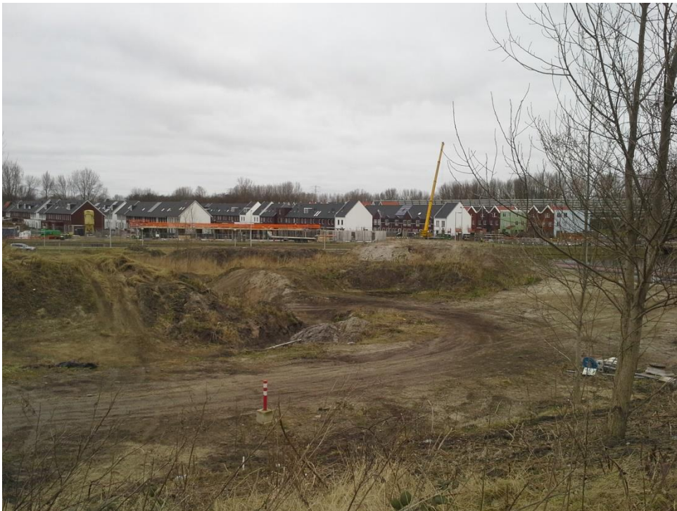
Foto 8: Zicht vanuit zuidoostzijde op een deel van de onderzoekslocatie (foto d.d. 10.02.15).
