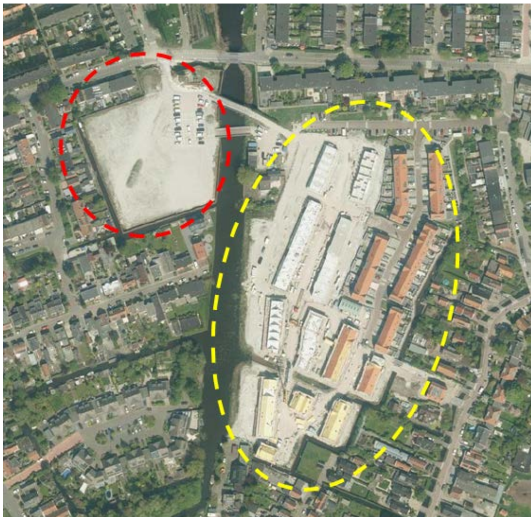
Luchtfoto plangebied met in rood globaal aangeduid het westelijke plandeel en in geel globaal aangeduid het oostelijke plandeel
